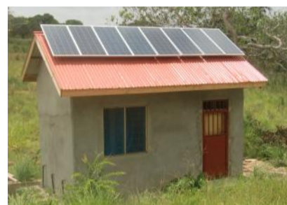
Elektrizitätshaus für Solaranlage Bauphase 1: 2000 Euro
